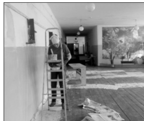
Частичная штукатурка и побелка стен в коридоре СОШ д. Хвощи.
