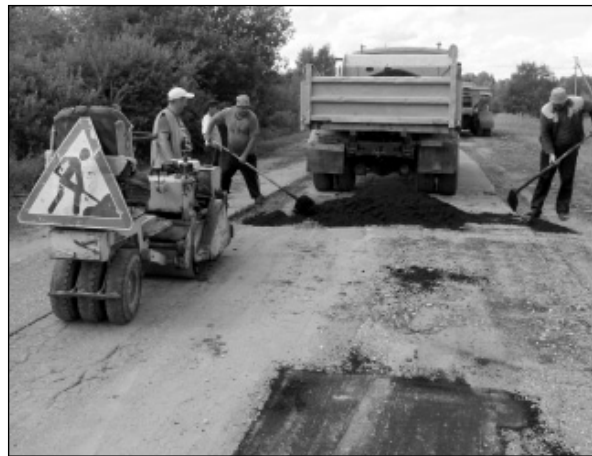
Рабочие ДРСУ проводят ямочный ремонт дороги Износковки - Ореховня.
