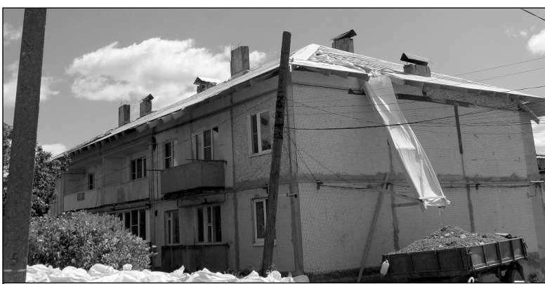
Ремонт крыши на ул. Новая, д. 2.
