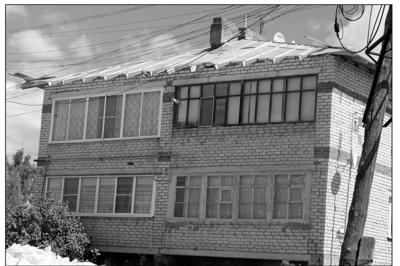
Ремонт крыши на ул. Мичурина, д. 1.
