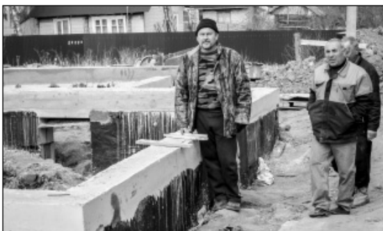
Депутат М.И. Пырсенков контролирует строительство нового двухэтажного 12-квартирного дома.
