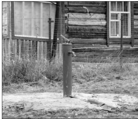
ПОСЛЕ ремонта новые, современные водоразборные колонки были установлены даже там, где воды в трубах не было более 20 лет.
