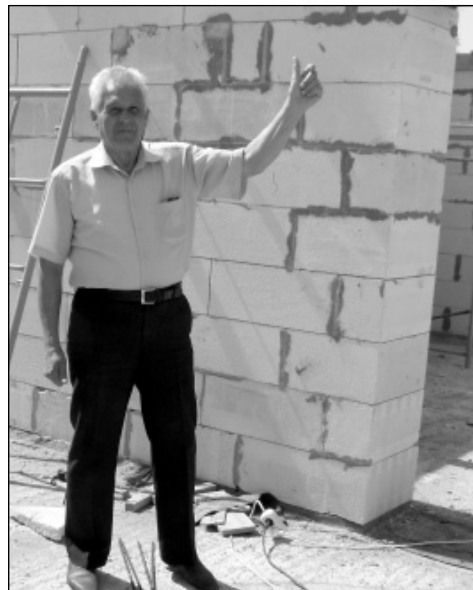
М.А.Шувальский курирует строительство очередного объекта.
