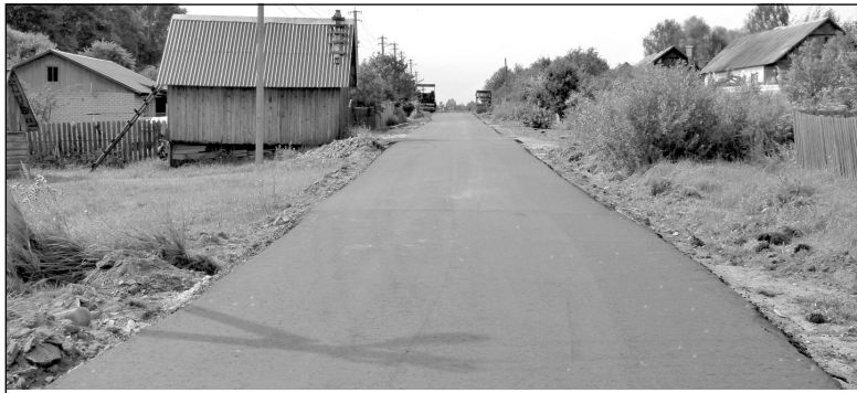
Дорога с. Износки ул. Плиева. 2020 год.
