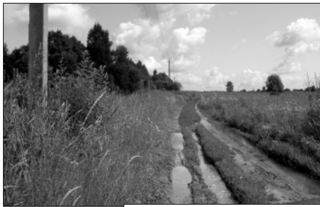
Дорога Леоново-Доманово ДО начала дорожно-восстановительных работ и ПОСЛЕ.
