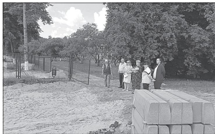
Пространство для отдыха в д.Хвоци. Контроль качества выполненных работ.
