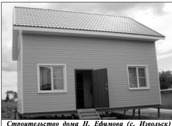
Строительство дома Н. Ефимова (с. Извольск) окончено.
