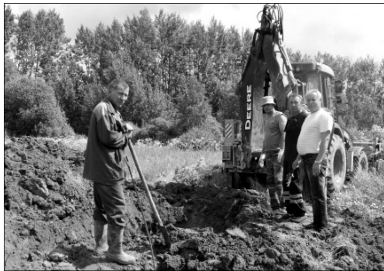
Ремонтные работы проводит бригада Износковского участка ВКХ.
