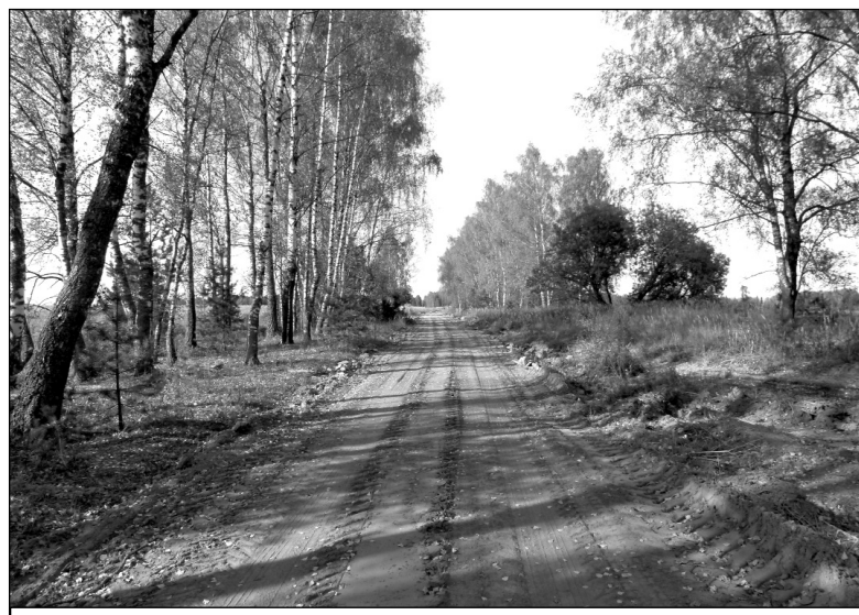
Отремонтированная дорога к урочищу Кулеши.
