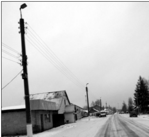
Такие современные энергосберегающие светильники установлены сегодня на улице Интернациональная в п. Мятлево.
