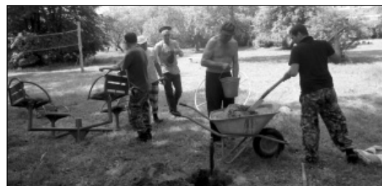
Идут работы по установке детского игрового комплекса.
