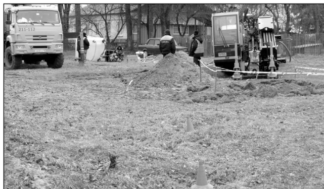
На месте ярких дорожных колпаков будет проложена новая водопроводная «трасса». Работа эта нелегкая, но очень нужная.
