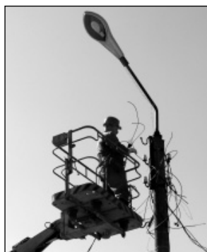
Ведутся ремонтные работы на высоте с гидроподъемника.
